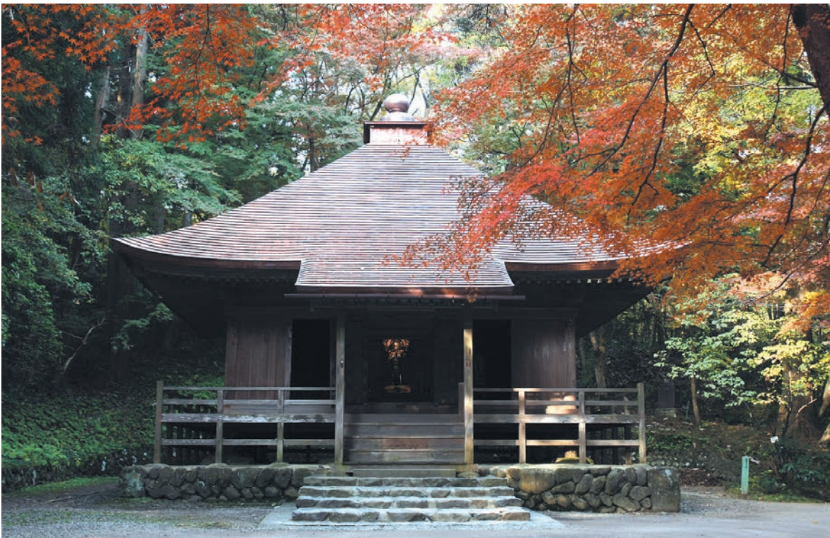
写真 2-23 東から見た経蔵 ©川嶋印刷株式会社
